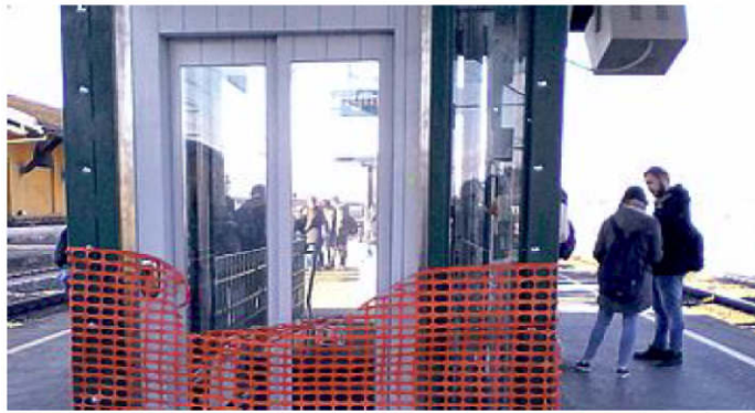
L'ascensore della stazione di Figline è ancora in attesa di essere messo in funzione
